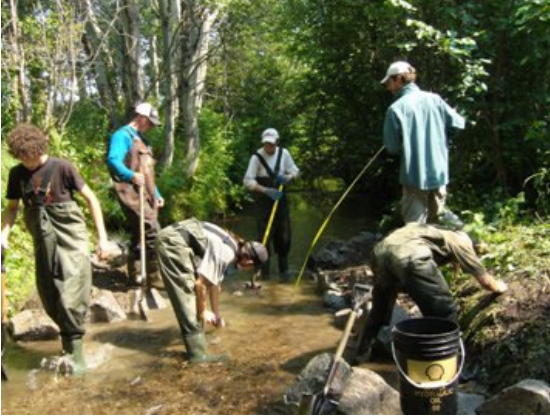
Construction d'un seuil
