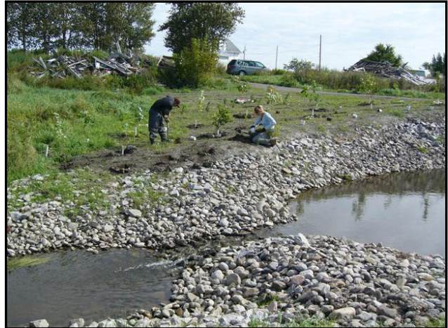
Restauration des berges d'un bassin de sédimentation
